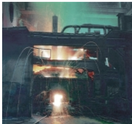
Дуговая сталеплавильная печь
